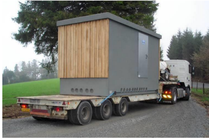
Illustration 6 : Arrivée d'un poste de livraison sur un site éolien
