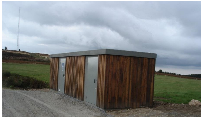
Illustration 7 : Poste de livraison du parc éolien du MARGNES (81)
